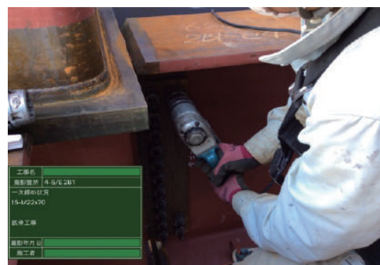
トルシア形高力ボルト一時締め状況
