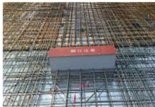
開口補強筋等確認
