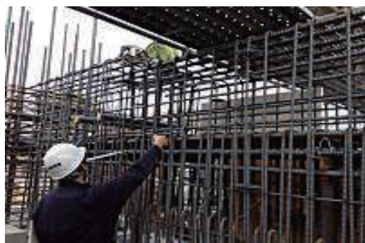
鉄筋径・本数・ピッチ確認状況
