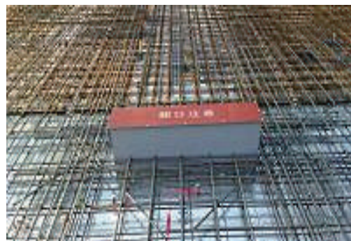
開口補強筋等確認
