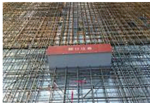
開口補強筋等確認
